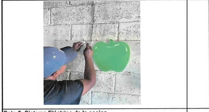
Foto 6: Sistema Eléctrico de la cocina
