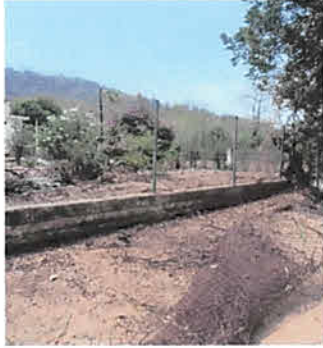
Foto 1: Reposición de malla de muro perimetral
