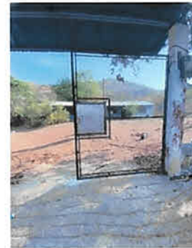
Foto 4: Mantenimiento de portón existente (chapa y pintura)
