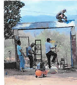
Foto 6: Mantenimiento de portón existente (chapa y pintura)
