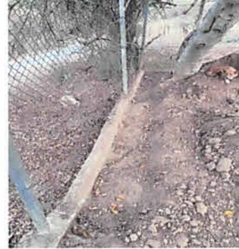
Foto 2: Reposición de malla de muro perimetral
