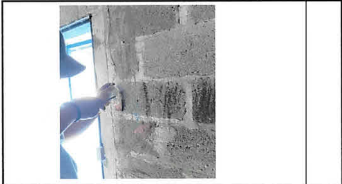
Foto 4: Sistema Eléctrico de la cocina
