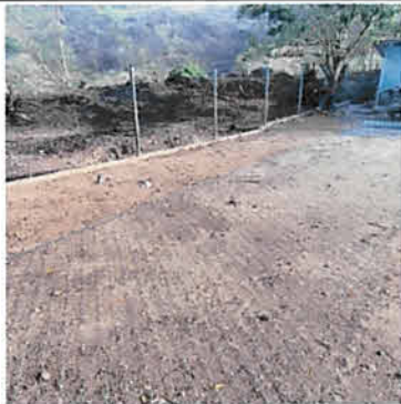
Foto 3: Reposición de malla de muro perimetral
